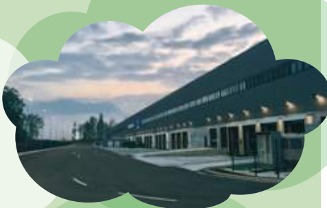
Visokoregalno skladišče Kuehne + Nagel
